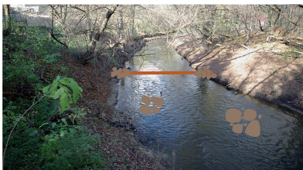
Ryc. 1. Drewniany próg stabilizujący oraz wyspy kamienne na materacach faszynowych na rzece Wełnie w Obornikach, poniżej elektrowni wodnej (fot. K. Szoszkiewicz)
