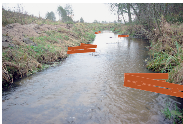
Ryc. 5. Propozycja usytuowania deflektorów drewnianych na Flincie, stanowisko Ninino (fot. K. Szoszkiewicz)
