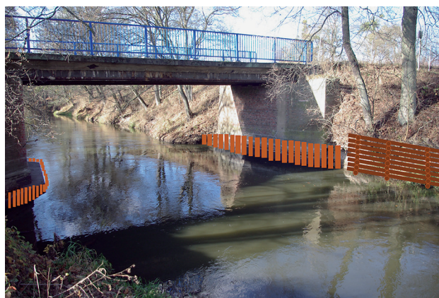
Ryc. 3. Wprowadzenie umocnień z lokalnych materiałów (Wełna-Jaracz) (fot. K. Szoszkiewicz)
